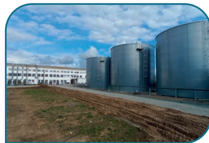
Les systèmes de détection et de défense incendie sont eux aussi renforcés par la mise en place de 3 cuves de réserve incendie et d'un réseau d'extinction dans tous les halls et les silos de compostage.
