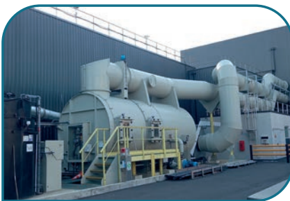
Les équipements étanches et la nouvelle installation de traitement de l'air augmentent le volume d'air traité sur site de 65% et permettent de supprimer les odeurs autour de l'usine.
